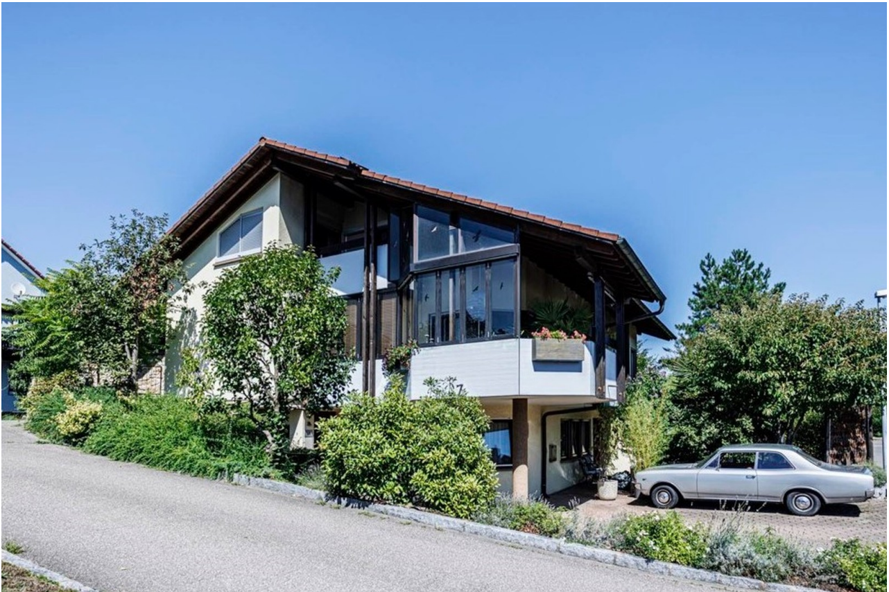
Architekten Haus mit Garten
